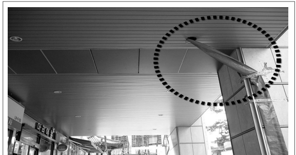
[그림 10] 엘보우 배관 막힘으로 역류 현상 발생
