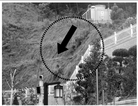
[그림 11] 법면 유실
