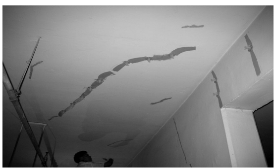
[그림 23] 지하주차장 슬라브 균열 보수
