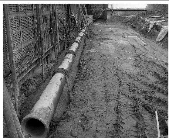
[그림 25] 연약지반 매립 시에 콘크리트 보강
