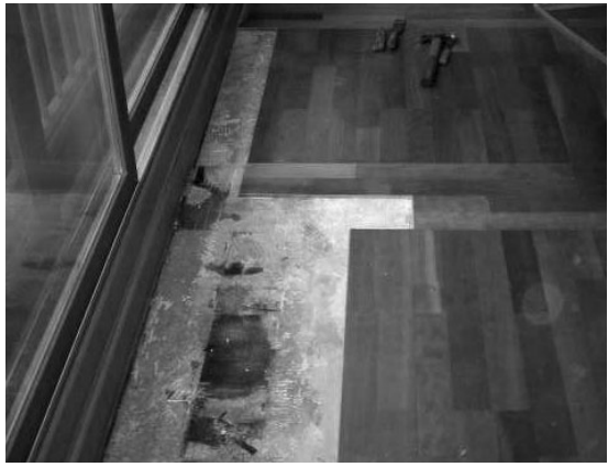
[그림 22] 거실 마루 철거, 교체 작업
